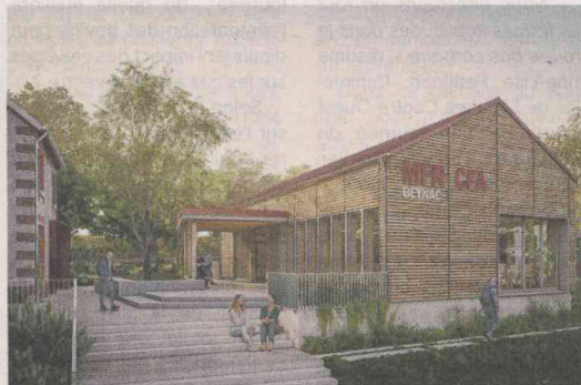
La MFR se dote de nouveaux bâtiments en tenant compte des dispositions dictées par le label Écolycée. (Ph. D. R.)
